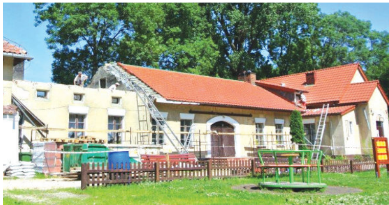
Kapitałny remont budynku Gminnego Centrum Kultury
