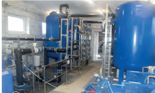
ZMODERNIZOWANA STACJA UZDATNIANIA WODY W RADZIEJOWICACH
