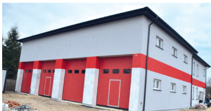
BUDOWA STRAŻNICY OSP W KUKŁOWIE ZARZECZNEJ
